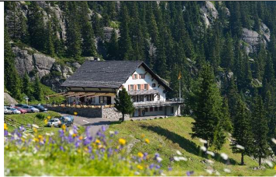
Das Berggasthaus Dammagletscher auf der Göscheneralp wird in den nächsten Jahren sanft renoviert.
